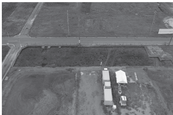
25E区調査区全景(東より)
