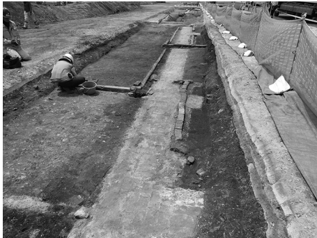
25Ab区 校基礎【愛知一中】と 戦後復興住宅基礎の重複 (東より)
