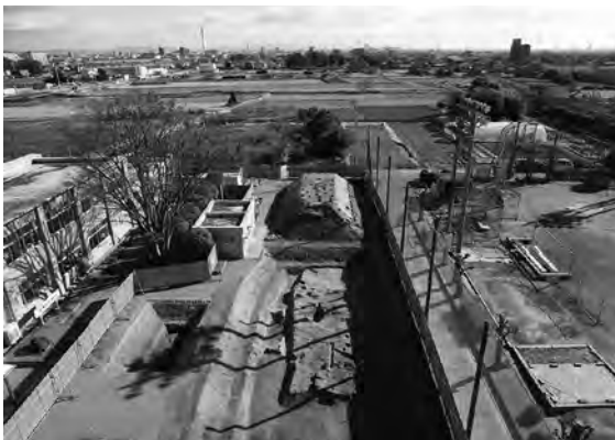
24Ab・B区全景(西から)
