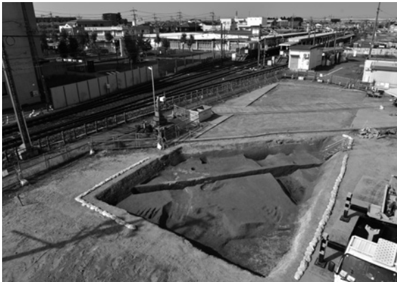
23Ac 区より西を望む (東から)
