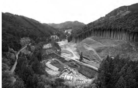
下延坂遺跡 全景(北東より)
