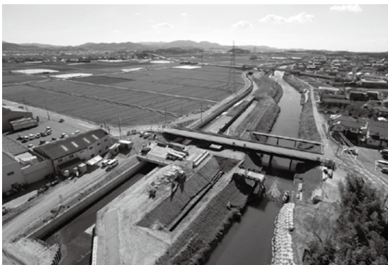
調査区全景(北から)
