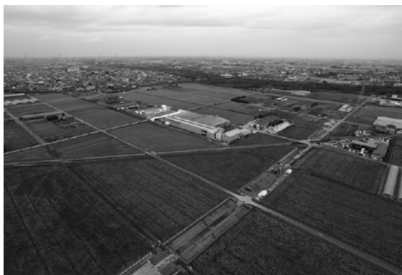
16A～E区遠景（北東より）
