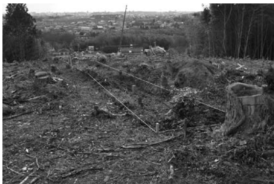
TT-01 掘削前状況 (東から)
