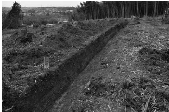
TT-05 土層断面 (南東から)
