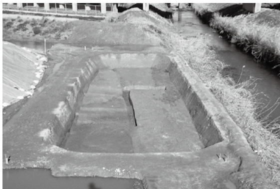
第2面全景 (南から)
