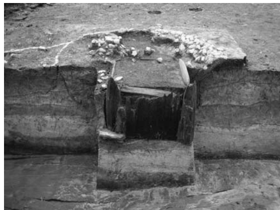
井戸断ち割り調査の状況
