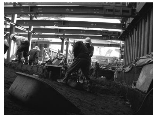
06C 区作業風景
