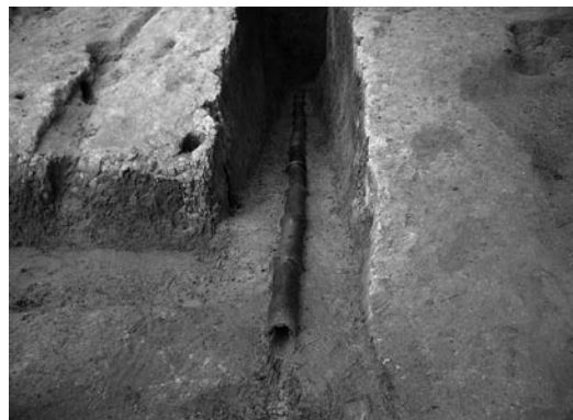
溜池の通水路
