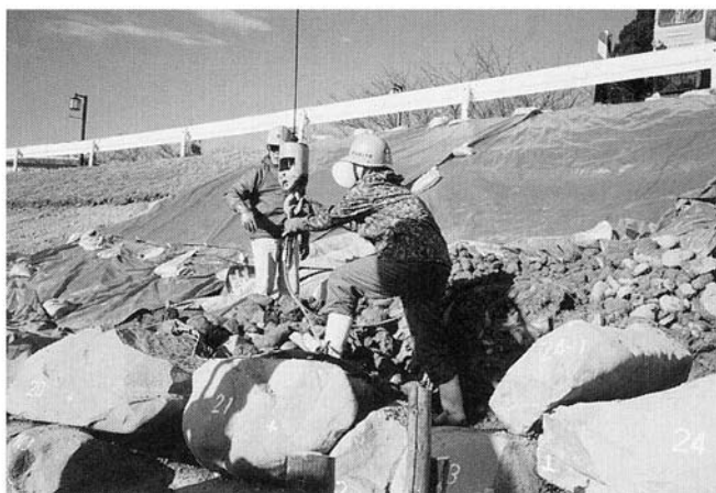
写真2 石垣の取り上げ
