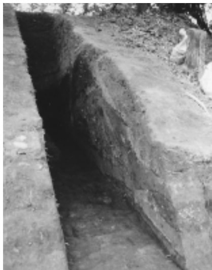
土塁断ち割り状況
