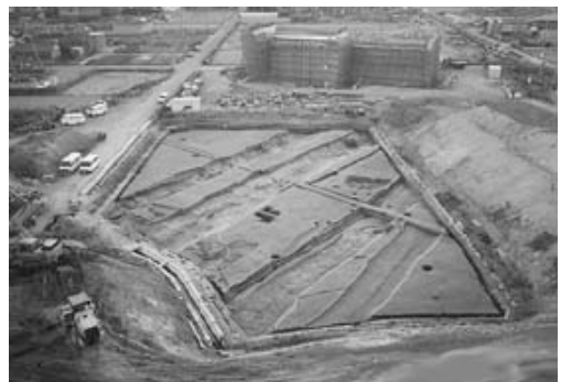
95A b区大溝
