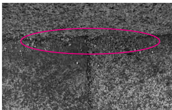
図6 真砂土化によって剥落した鉢物(北から撮影)
