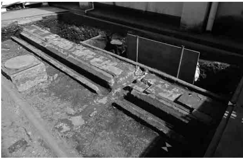
①愛知県第一中学校校舎基礎【24D区】(北西より)
