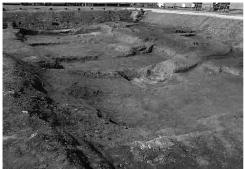
④県立明和高等学校旧本館基礎【24B区】(東より)
