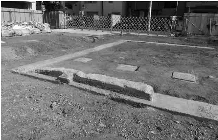
②名古屋帝国大学学生食堂基礎【24B区】(北西より)
