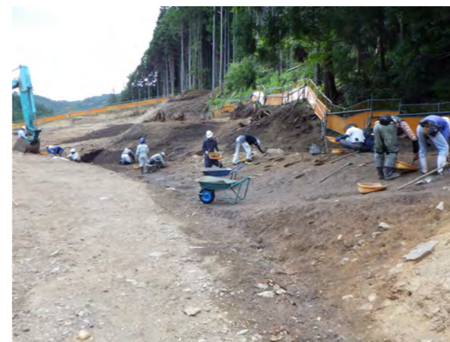
21A区作業の様子
