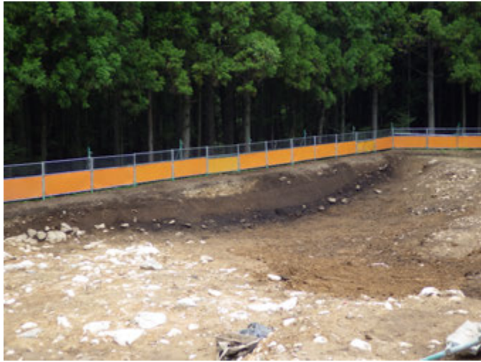
20Ac 区で検出された谷地形 (東から)
