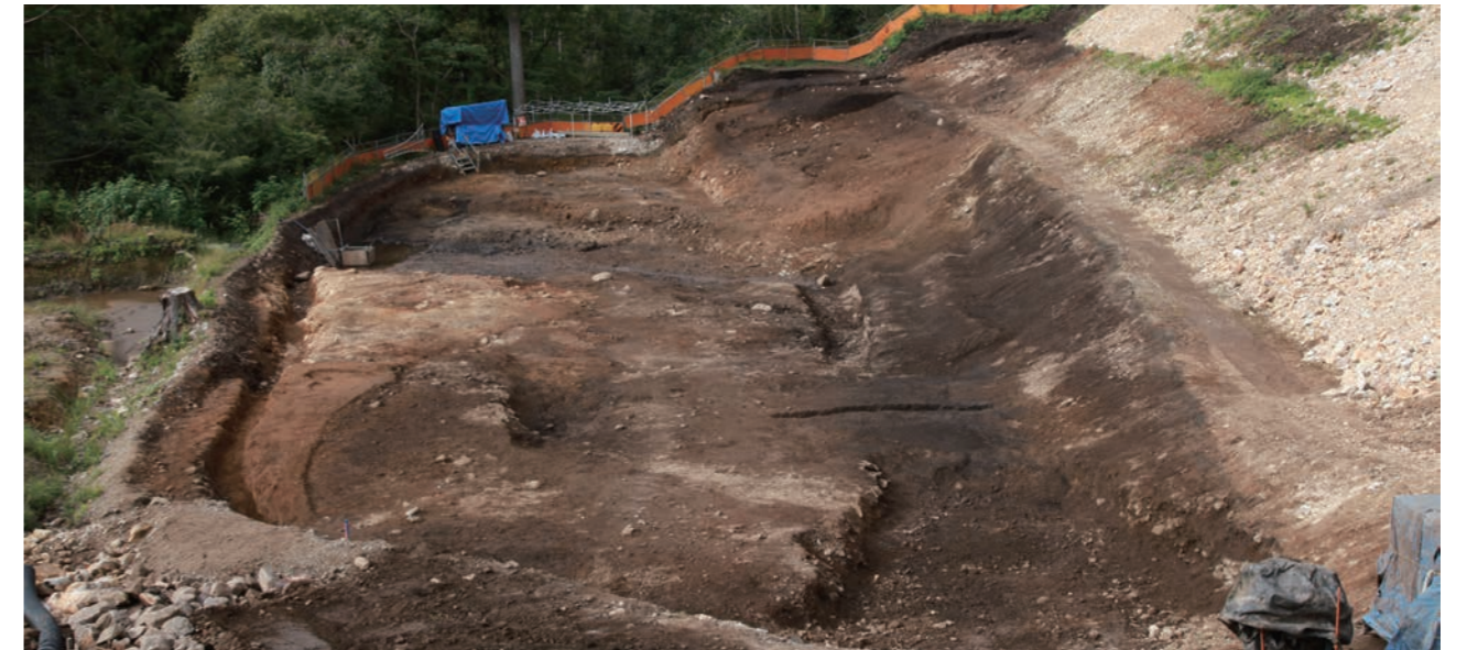
19C区全景(東から)
