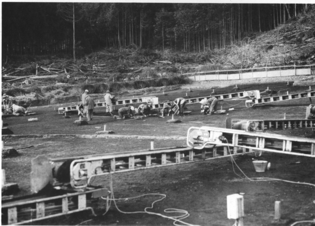
作業風景 (南東より)
