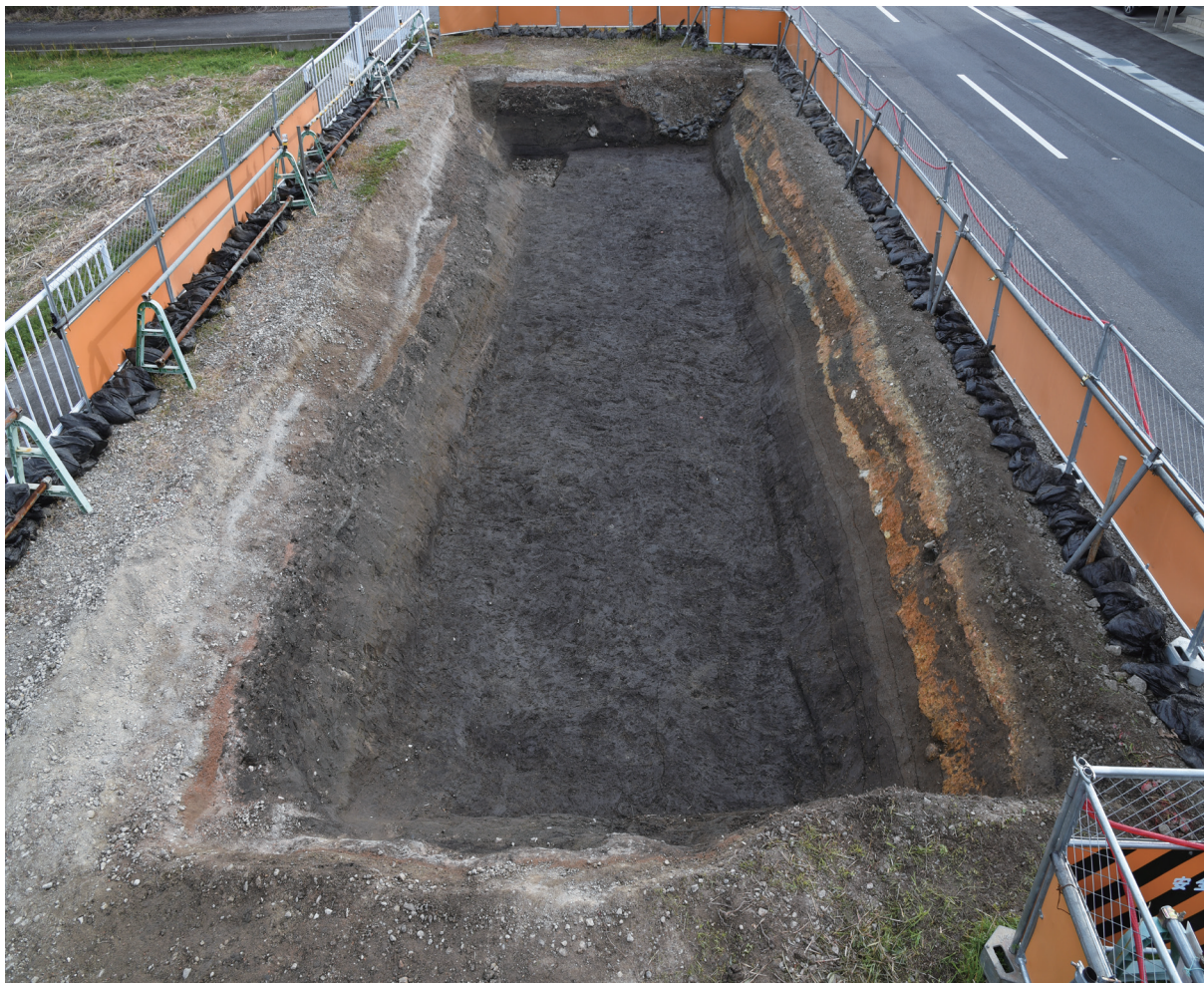
Da 区完掘状況（東より）
