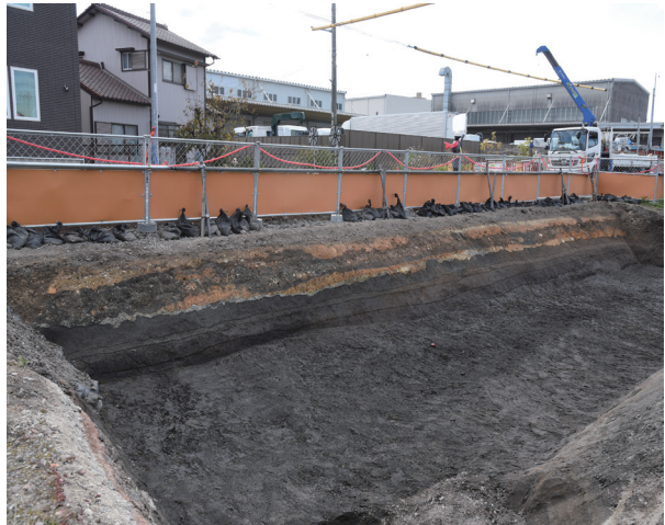
Da 区南壁セクション壁（北東より）
