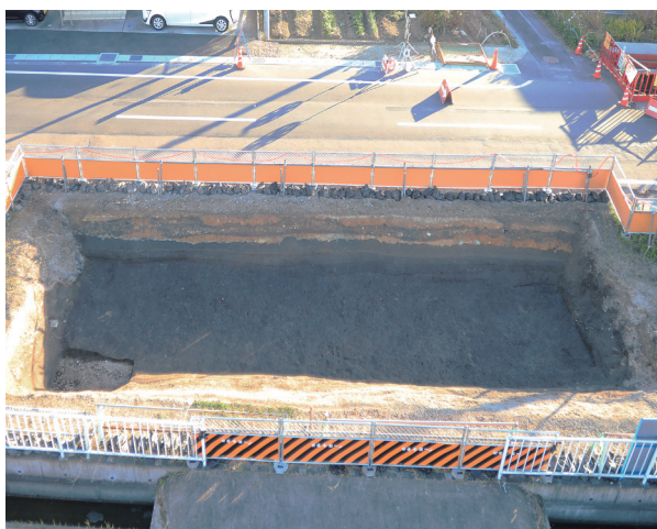
Da区完掘状況（北より）
