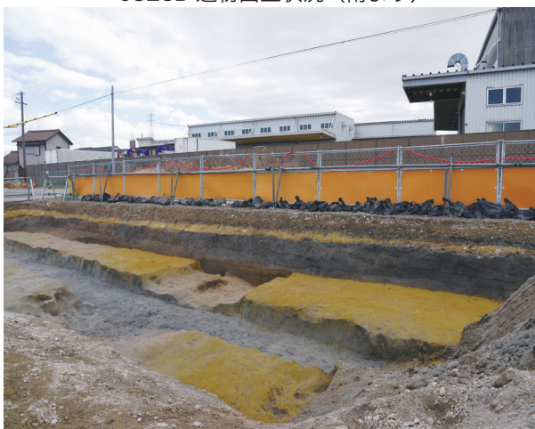
Eb 南壁セクション (北西より)
