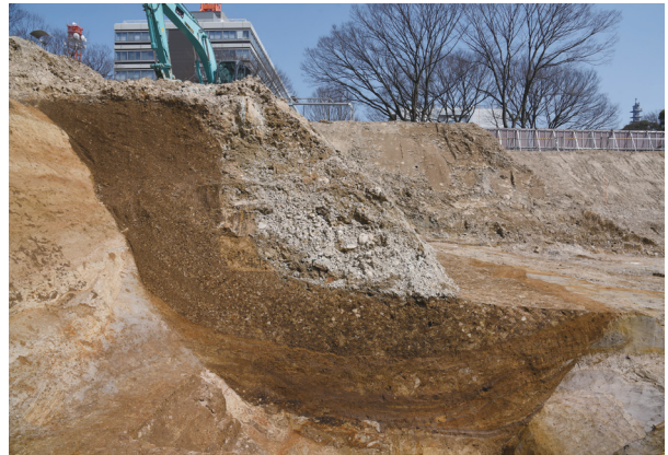
大溝 315SD 埋土断面 (西から)
