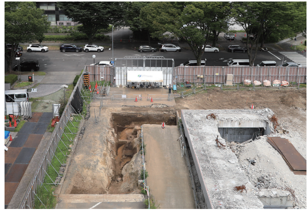
23Aa 区下面全景 (西から)
