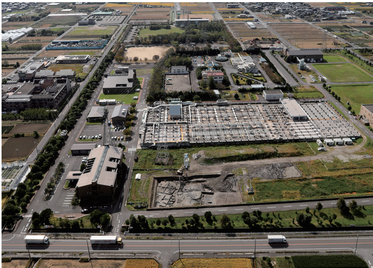
18区遠景（北より：手前の道路は県道馬飼井堀線）
