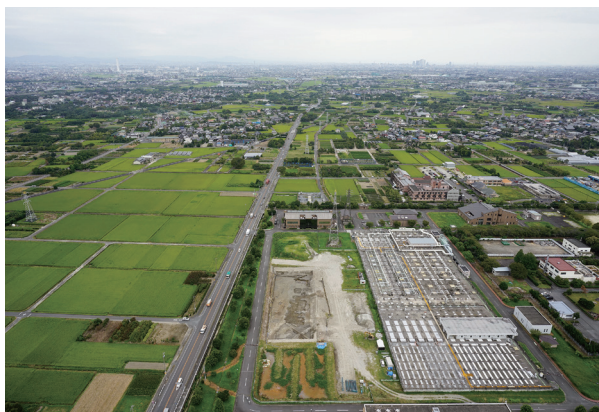
19区 遠景 (西より)
