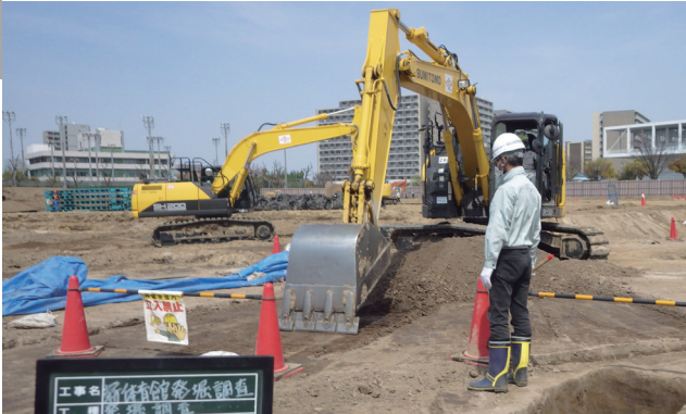
重機による表土の掘削
