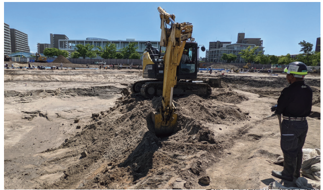
重機による旧河道の堆積土掘削
