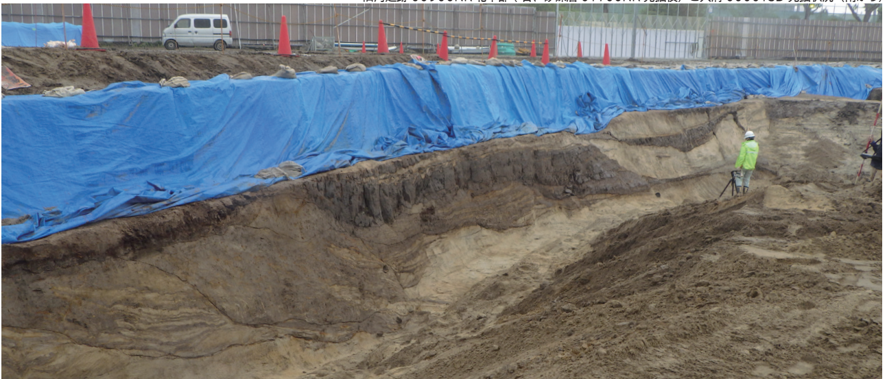
旧河道跡 00900NR 調査区北西壁土層断面全景 (南から)
