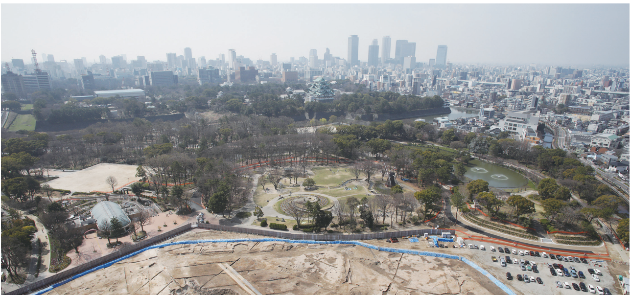
写真3 名城公園北園からみた名古屋城(2022年3月全景撮影時、北から)
