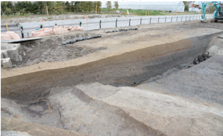
19Ba 区（西部）一色城の東堀 464SD 土層断面（南西から）
