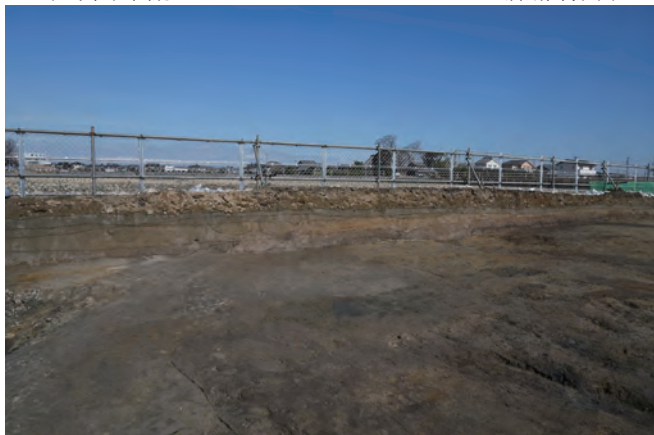
20B区北壁土層断面(南西から)
