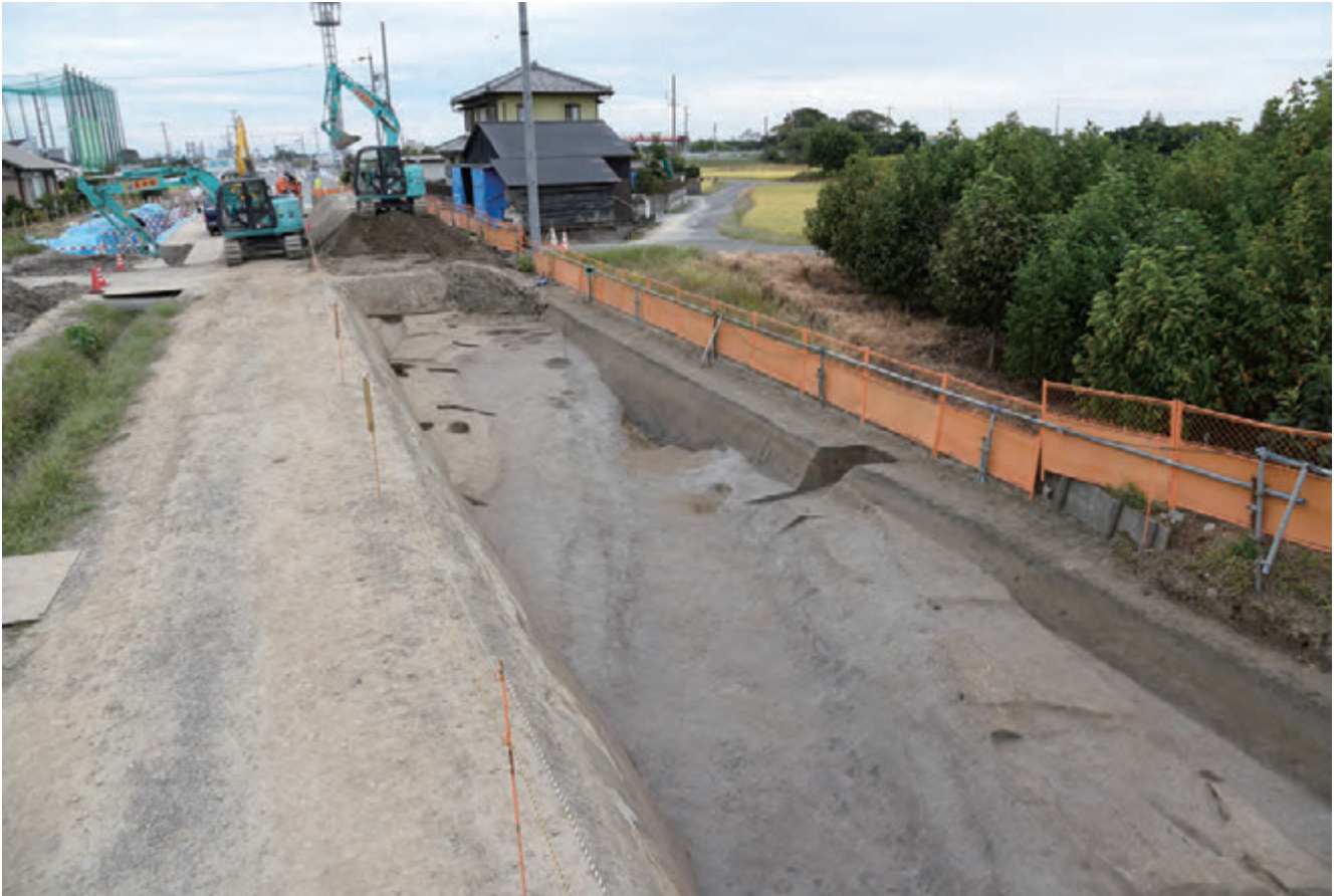
19Ca 区村境の溝 194SD 完掘状況（北西から、溝の延長上に現代の道が地割として残存している）
