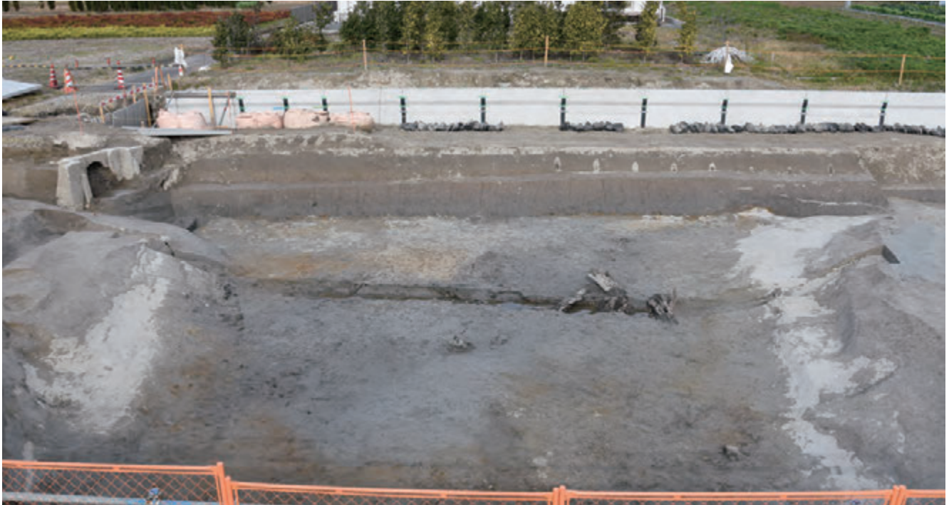
19Ba 区（西部）一色城東堀 464SD 完掘状況（南から、下位旧河道の堆積中にある流木の一部が堀底に露出している）
