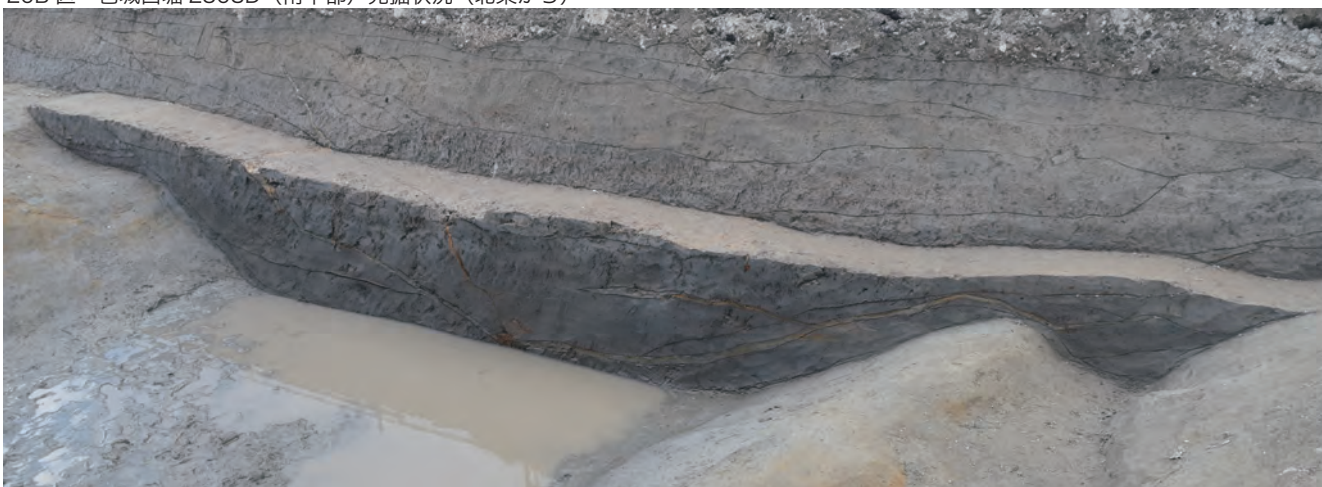
20B 区一色城西堀 230SD 土層断面 (北西から、調査区南壁)
