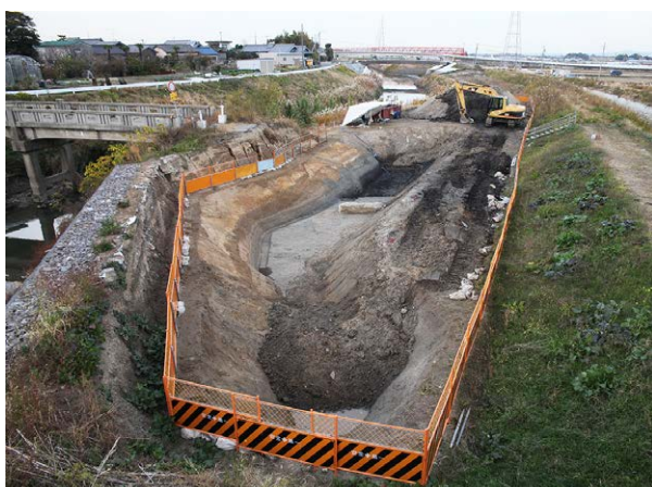
3面全景（南より）
