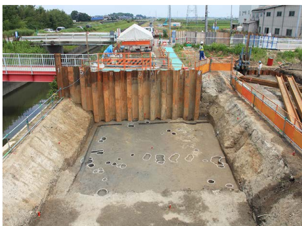
C 区全景（南東より）
