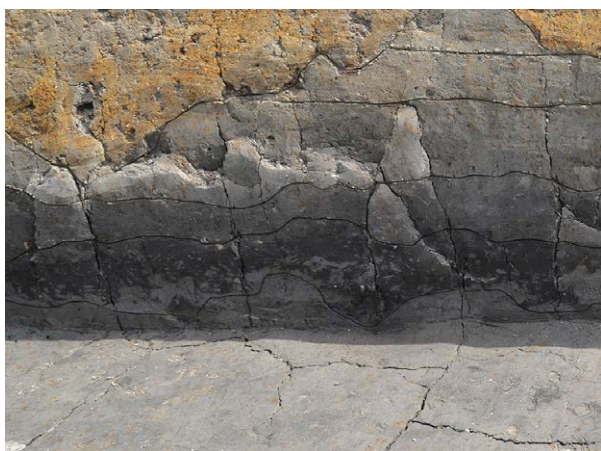
C 区攪拌土壌土層断面（西より）
