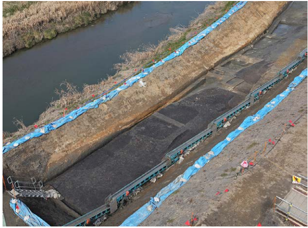
B 区 1 面南部（南より）
