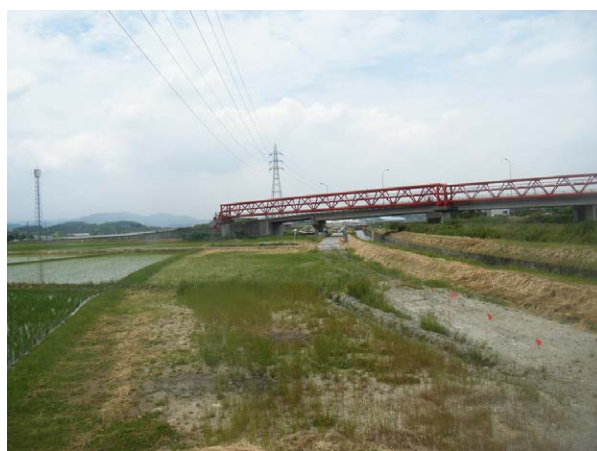
A 区調査前風景（北より）
