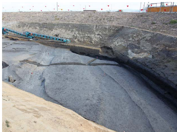
A 区 NR01（西より）
