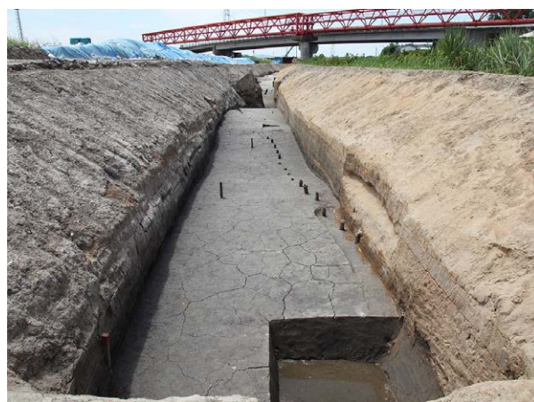
A区北部（北より）
