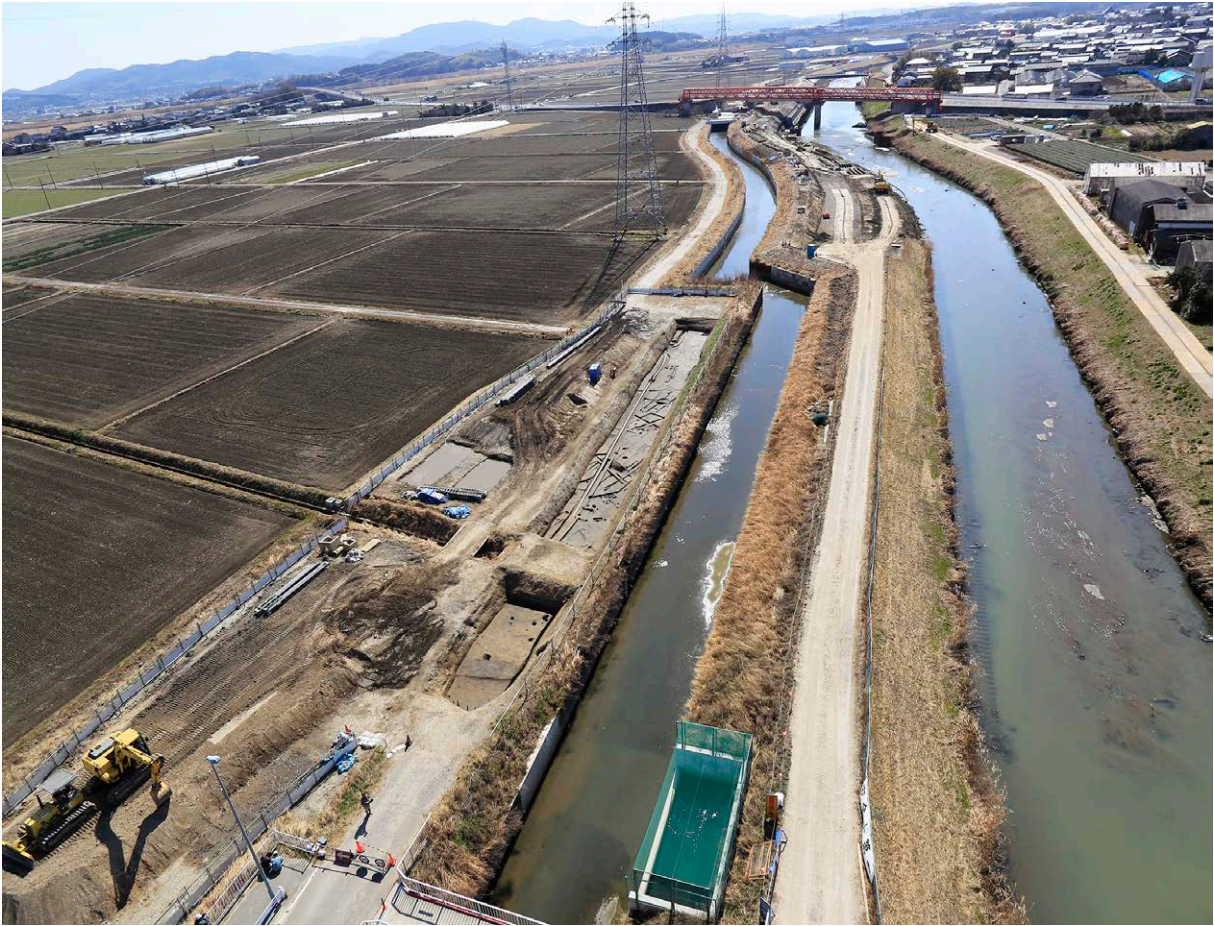
C 区 2 面全景（北西より）
