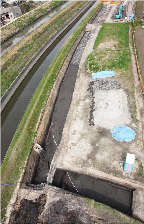
C 区 2 面全景（南東より）
