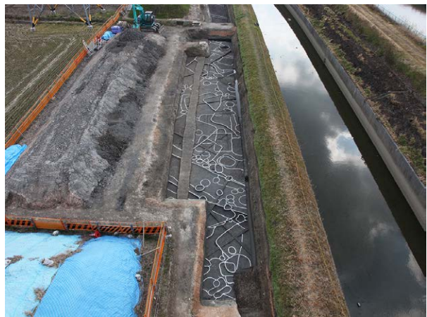
D 区 2 面全景（北より）
