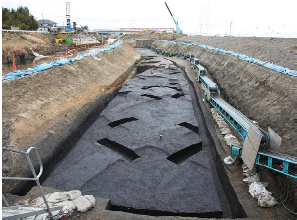
B 区 2 面南部（南より）
