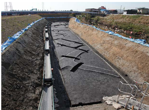
A 区 2 面全景（北東より）
