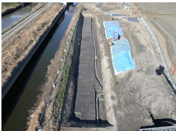
C 区 1 面全景（南より）
