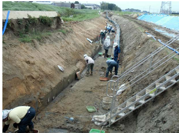
A区作業風景（南より）
