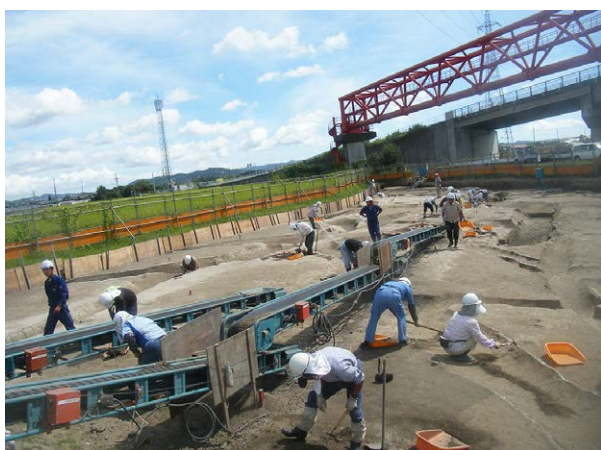
A 区調査風景（北西より）
