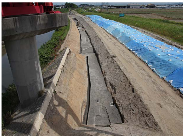
A区全景（南より）
