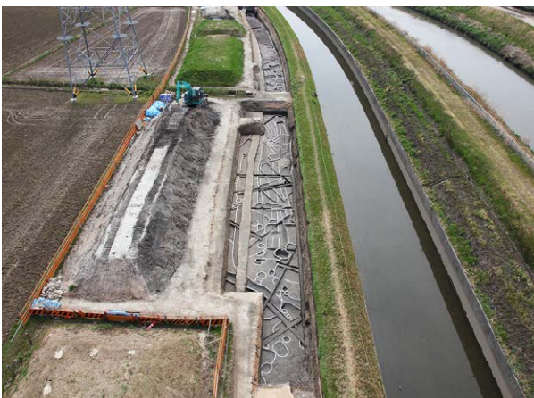
D 区 4 面全景（北より）
