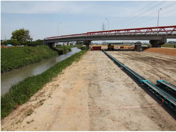
調査前風景（南より）
