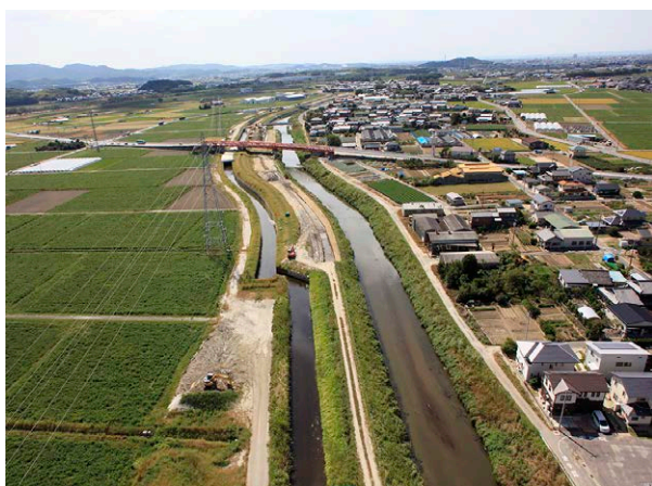
B区調査区遠景（北より）
