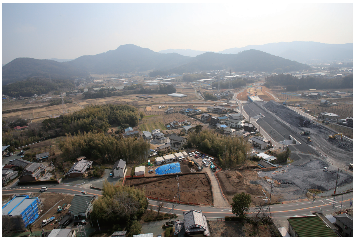
調査地点遠景（北西から）
