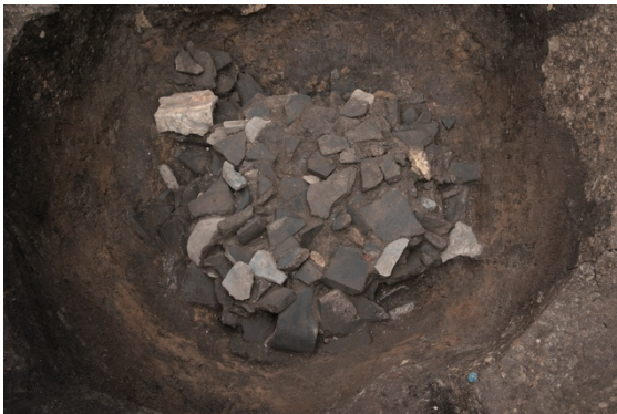
図7 水琴窟②の地下構造（甕の下）
