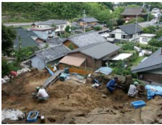
022作業窯体掘削0
