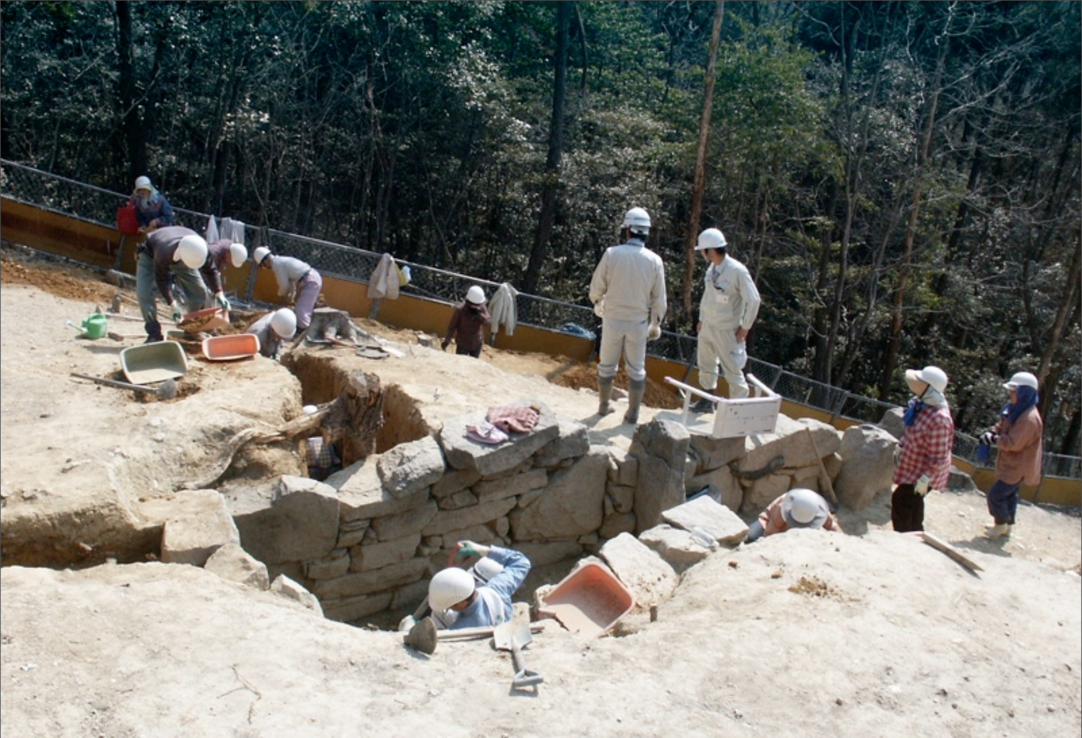
石室の解体・墳丘の断ち割り
