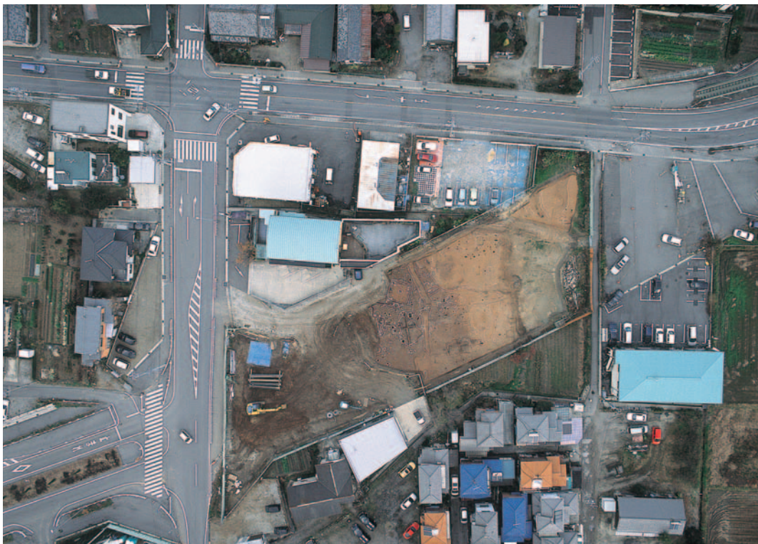
(2) C区全景（俯瞰）
