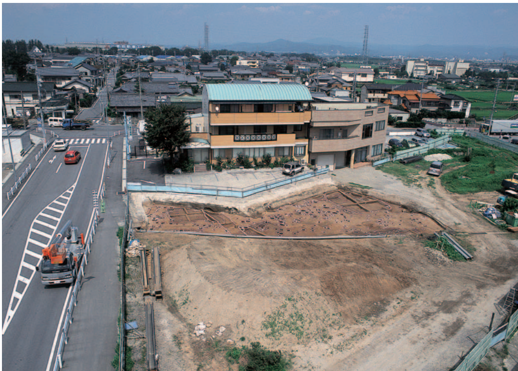
(2) A区全景（南より）
