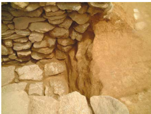
SZ01 横口部段構造の石積み・裏込土除去状況（北西から）
