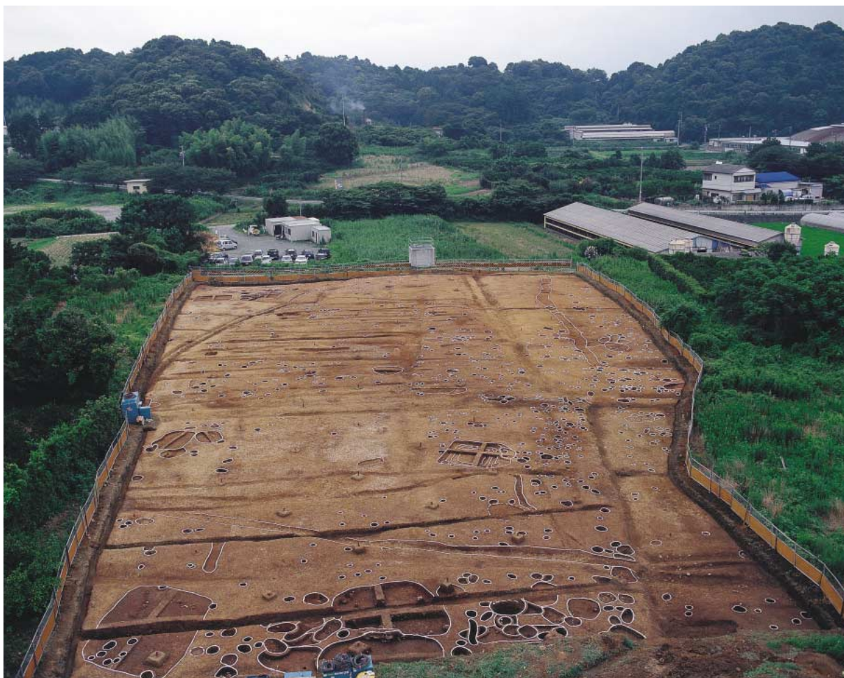
(2) A区全景（南西より）
