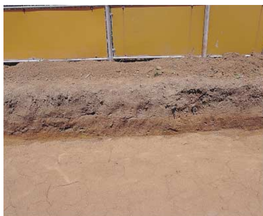
(18) A区 壁セクション (南より)
