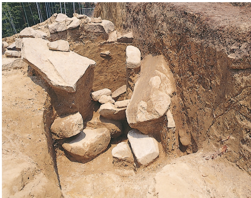
石室左壁崩落状況 (東から)
