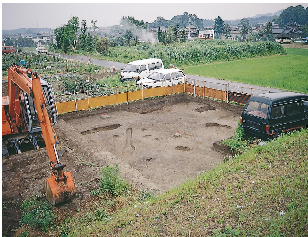
99A区全景 (北東から)
