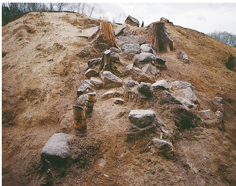
石室開口部崩落状況 (南西から)
